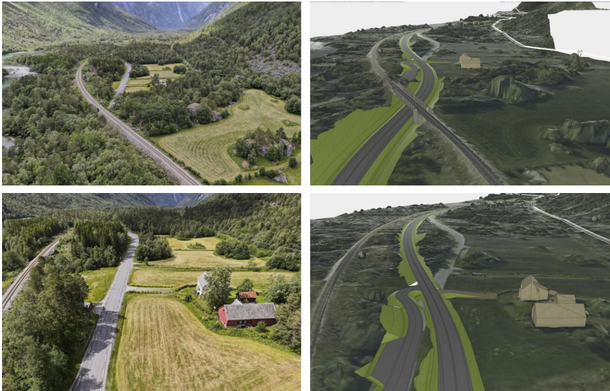
Figur 86: Dronefoto ved Skirimoen til høyre. Til venstre øverst vises ny jernbanebru og nederst ny situasjon forbi gårdstunet. Ny veitrasé vil få et større fotavtrykk og vegetasjon/terreng vil endres en del. Foto: Grindaker/ Trimble connect.
