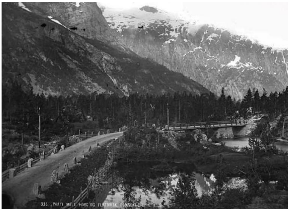
Figur 42 Kjørevegen fra 1869 Utøyan. Her var det tidligere bru da elva Rauma dannet en arm ved Skiri. Denne delen av elva ble tettet igjen ved byggingen av Raumabanen. Foto: Knud Knudsen, ca. 1870. Kilde: Universitetsbiblioteket i Bergen, ubb-kk-1318-0336.
