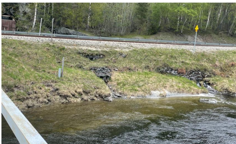
Figur 56 Oppmurte kulverter under jernbanelinjen. Foto: Asplan Viak.
