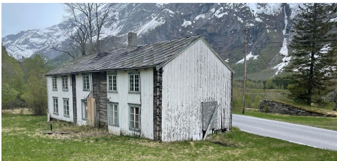
Figur 65 Låna på Ytre Monge. Restene etter låvebrua skimtes på den andre siden av Romsdalsvegen. Foto: Asplan Viak.
