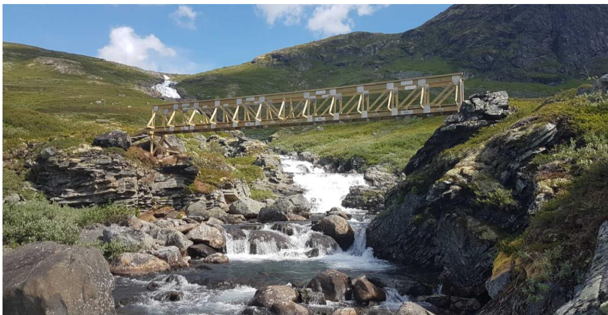
Figur 7-10: Høystakka i Jotunheimen.agverksbru i tre med spennvidde 18m, prosjektert av AAJ for DNT. Foto: Plan
