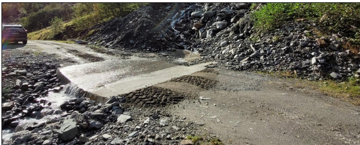
Figur 5-2 Eksempel på vadebru i Fortunsdalen (foto: Asplan Viak). Det bør støpes inn et lite rør for å ta unna normalvannføring.
