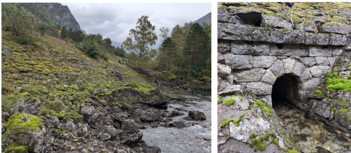
Figur 6-19: T.v. Jernbanefyllingen ved kulverten, der nedre del er fint steinsatt. T.h, Den fredede kulverten på Utøyen som leder bekken Kvernagrova under veien og jernbanen. Foto: Plan AAV
