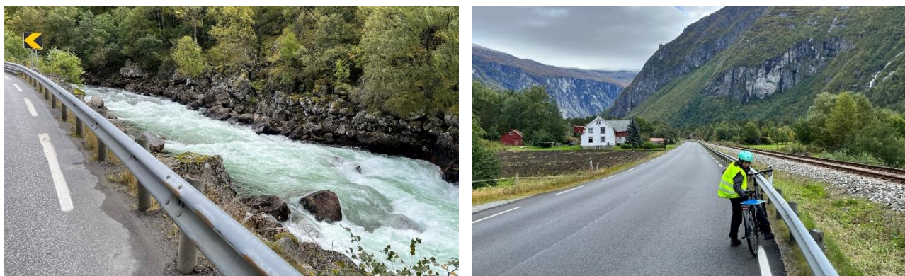
Figur 3-1: Dagens vei har svært begrensede muligheter for trygg ferdsel langs veien, eller for å stoppe og oppleve det flotte landskapet. T.v. ved Kjerkjefossen/Flatmark, t.h. ved Skiri. Foto: Plan AAV
