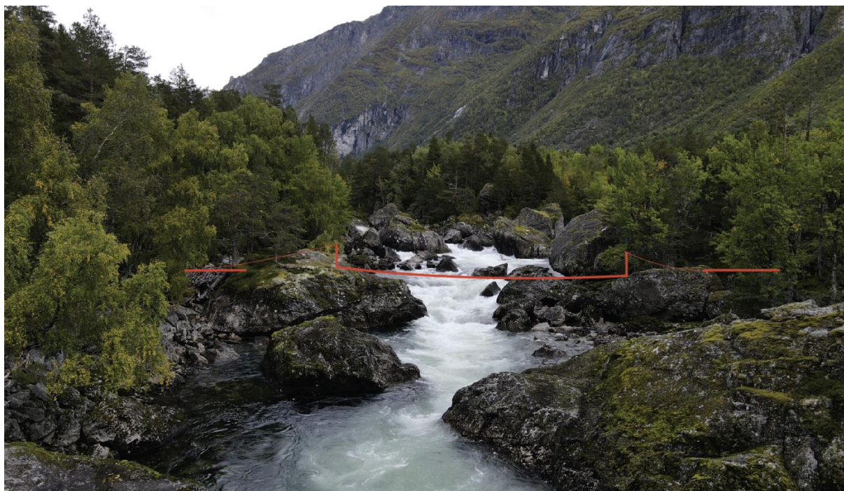
Figur 7-53: Lokalisering av krysningspunkt over Rauma. Bilde tatt ved lav vannstand. Kilde: Plan AAV
