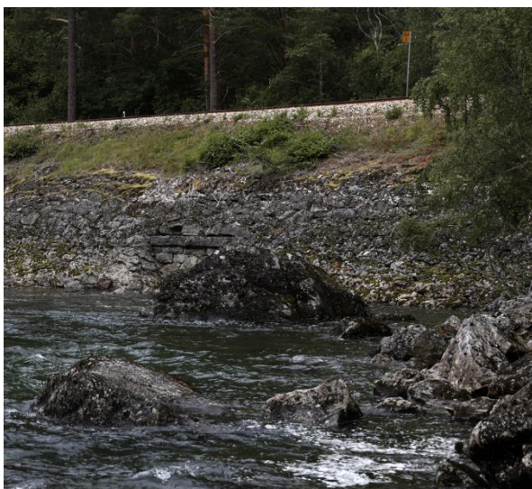
Figur 7-54: T.v. Jernbanefyllingen som er fint steinsatt i nedre del, der den fredete kulverten så vidt synes. Bru må ikke komme i konflikt med kulverten. T.h. Kongeveien/Chausseen ved Årstallsteinen.
