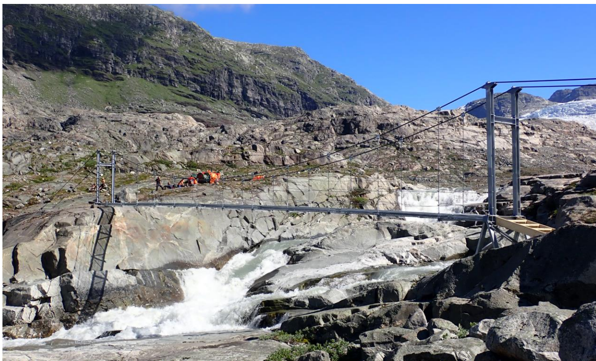
Figur 7-5: Rembesdalsskåki hengebru med spennvidde ca. 32m prosjektert av AAJ for DNT. Foto: Plan AAV
