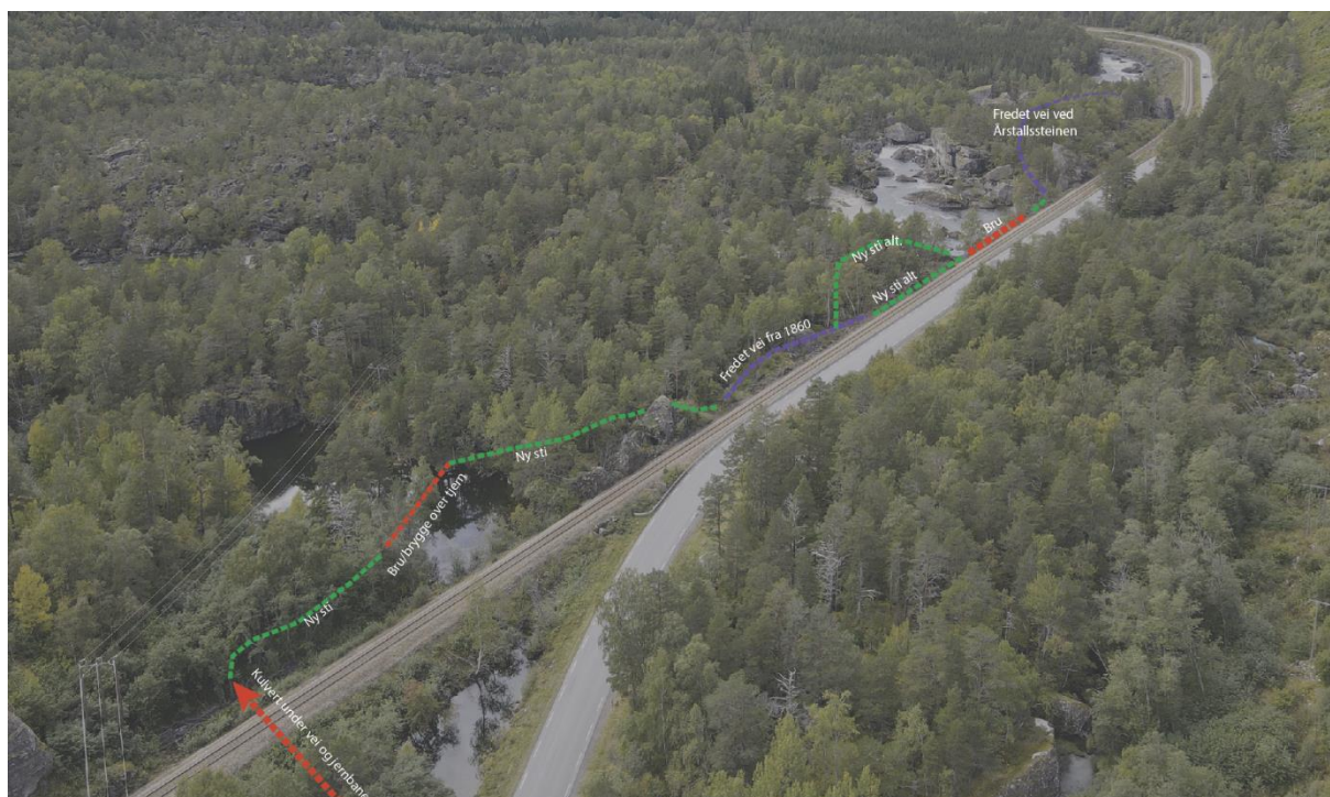
Figur 7-50: Dronefoto av strekningen fra ny kulvert, med kobling mot Årstallssteinen via fredet veifar. Kilde: Plan AAV
