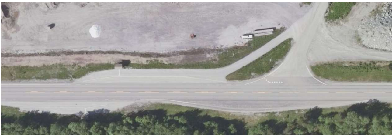
Figur 4.7-2 Ortofoto av vegkrysset E136 x Hovdevegen med busslommer på begge siden av E136 og et lite stykke opparbeidet g/s-veg, Kartverket
