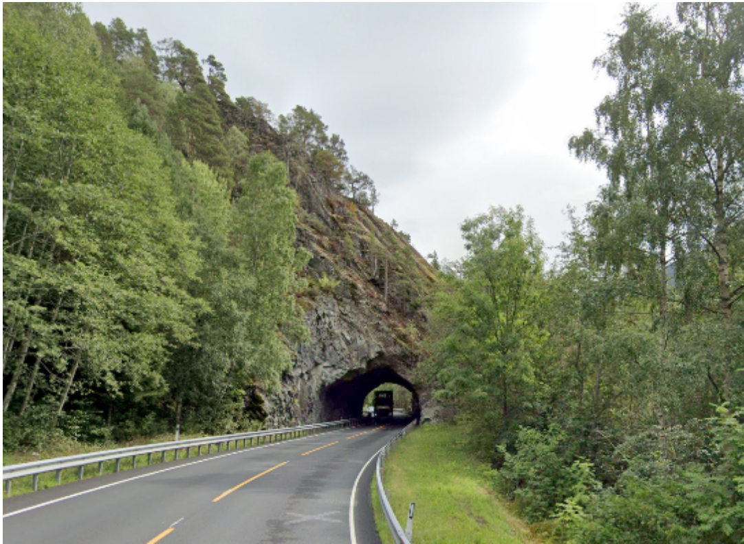
Figur 4-1: Vikenøstunnelen, sett mot øst. (Kilde: Google Street view, 06.10.2021).
