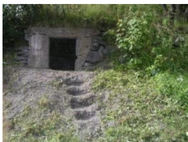
Figur 29 Vinkjellerens inngang. Kilde: 6310 VEBLUNGSNES I ROMSDAL
