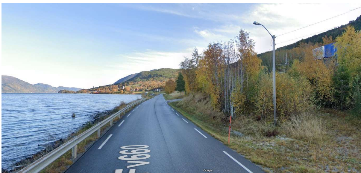
Sikt mot avkøyringa langs fylkesvegen frå vest, Google streetview
