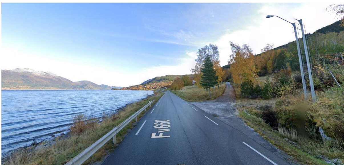
Avkøyringa og tilkomstvegen for tiltaket, Google streetview
