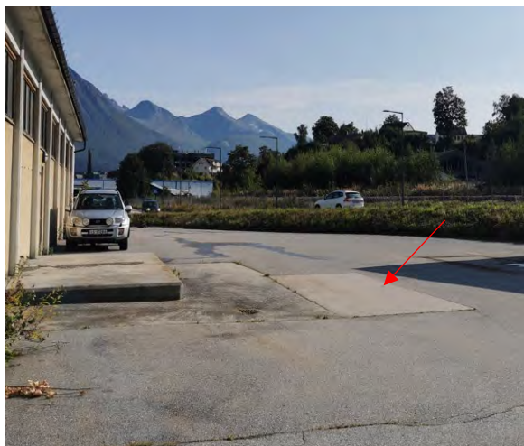
Figur 15: Betongplate hvor det tidligere stod en dieselpumpe
