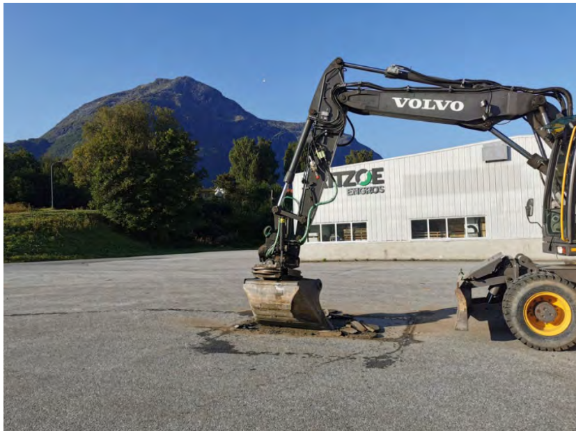
Figur 22: Graving av prøvepunkt P1
