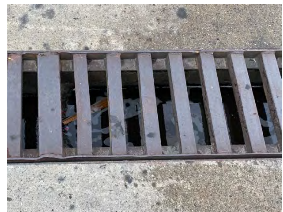
Figur 19: Oljefilm sett på overflaten av vannet i risten nord for bygget
