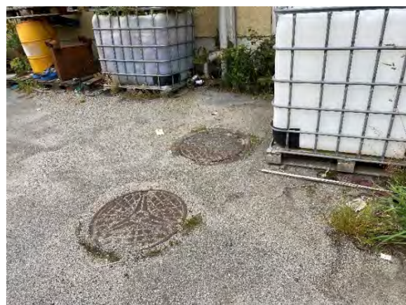
Figur 18: Kummer til trolig oljeutskiller på nordsiden av bygget
