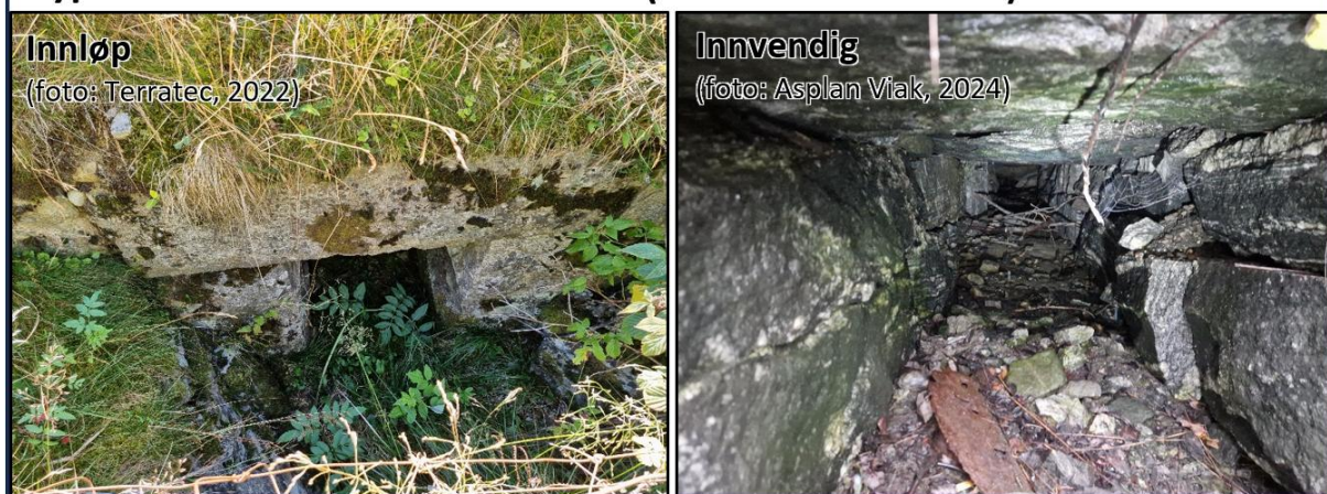
Figur 4-4 Bilder av typisk utforming og tilstand på mindre stikkrenne i stein som ligger flere steder i både vei- og jernbane.
