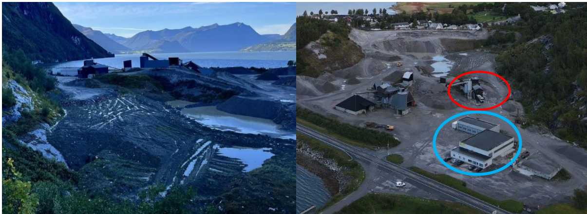
Figur 4-7 Oversiktsbilde og dronefoto tatt av Veblungsnes sandtak. Rød markering viser betongproduksjon inkludert vaskehall med utvendig spyling langs planlagt vegtrase, blå markering viser verksted og garasjeanlegg.
