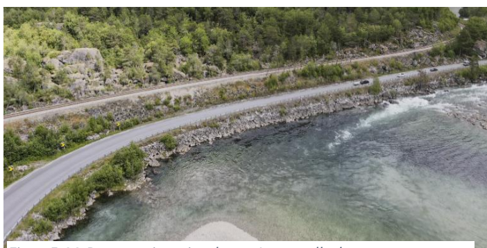
Figur 5-22 Dagens situasjon langs Jetmundhølen.
