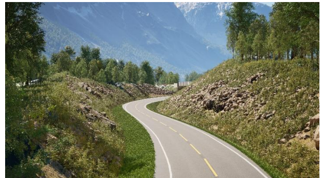
Figur 5-25 Tverrprofil ved Kjerkjeura, med reetablering av ura i veiskjæringene. Dette legges opp så bratt som mulig.
