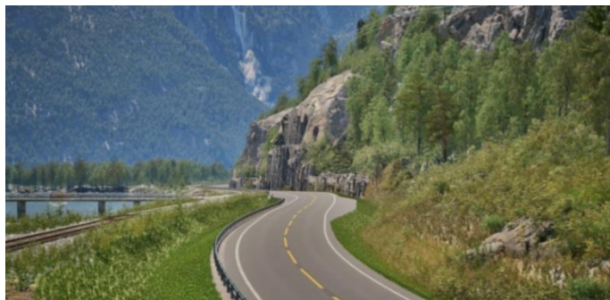
Figur 5-43 Fjellskjæring ved Mongehamran.
