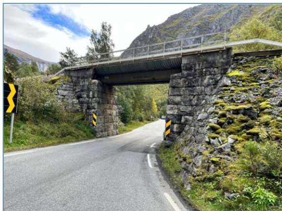
Figur 4-5 Jernbaneundergang ved Skirimoen. Kilde: AAV.
