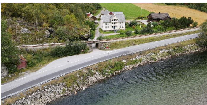
Figur 5-19 Dagens situasjon med vei og fylling langs Nordre Flatmark.
