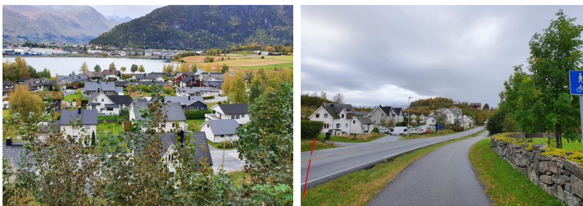
Figur 4 T.v. vises Veblungsnes sett fra masseuttaket mot Åndalsnes. T.h. dagens E6 gjennom Veblungsnes sett fra Grytten kirke.
