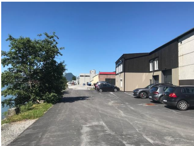
Figur 5-2: Foto av etablert lensmannskontor, langs Rauma.
