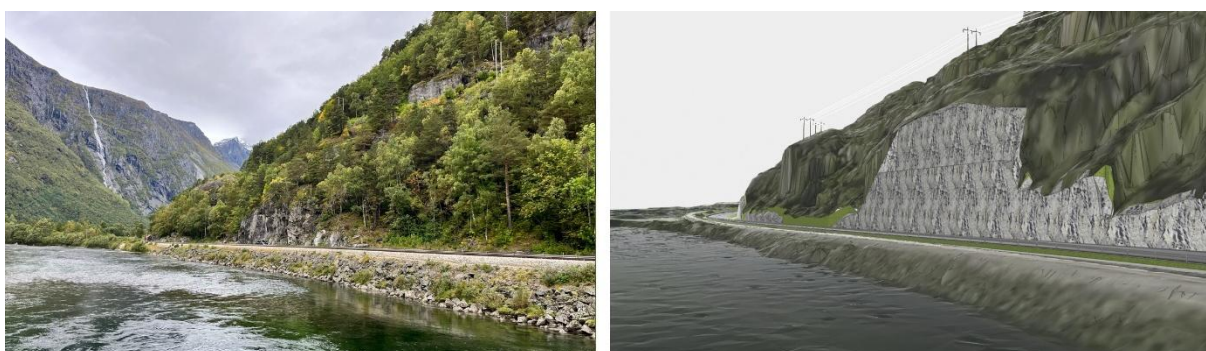
Figur 130: Foto og visualisering av veien langs Mongehamran sett fra Remmem bru. Veiens bredde med fanggrøft gir en fjellskjæring på ca 30 m. Kilde: Grindaker/Trimble Connect
