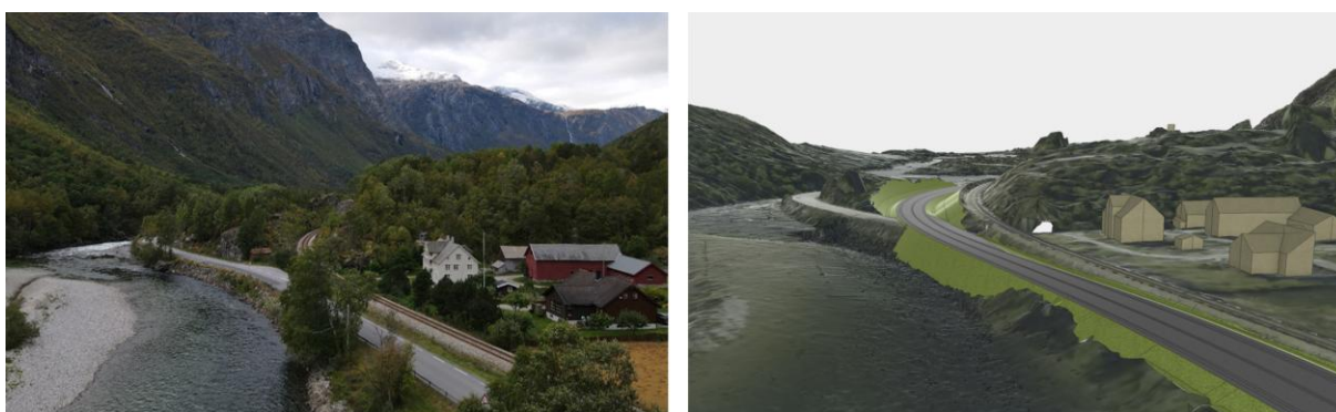
Figur 4-44: Dronefoto og visualisering av Nordre Flatmark med Kjerkjeura og Kjerkjefossen i bakgrunnen. Eksisterende veifylling i elva er tydelig, og kantsonen lite naturpreget i dag. Forbi Nordre Flatmark heves veien og fyllingen i Rauma reetableres. Kilde: Grindaker/Trimble connect
