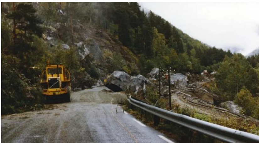
Figur 33: Steinras 18. september 1986 i Mongeura. Foto: Terje Lindstad, Norsk vegmuseum
