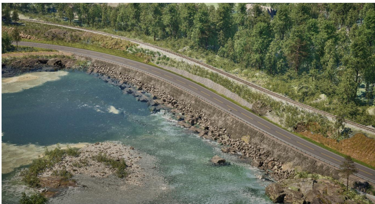
Figur 103: Visualisering av erosjonssikret elveskråning ved Jetmundhølen og natursteinsforblendet jordarmering i jernbanefyllingen. Kilde: ViaNova
