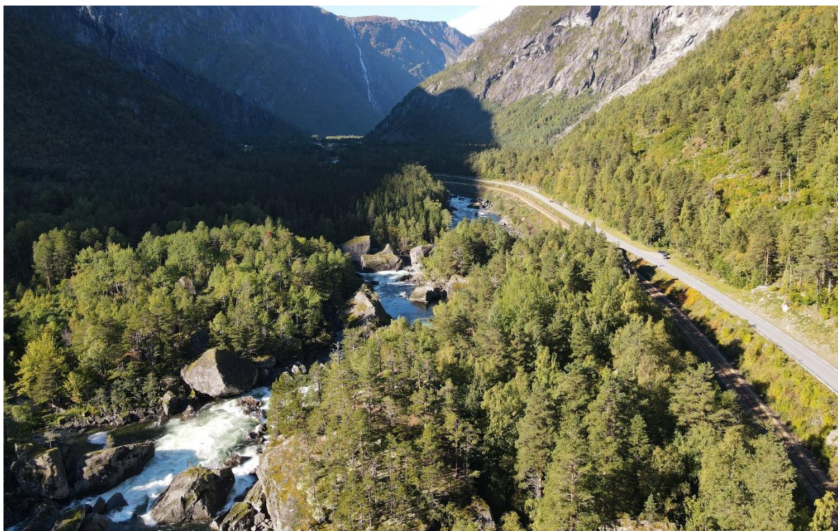
Figur 76: Landskapet av store rasblokker preger elva og skaper stryk, fosser, delte løp og øyer. Vei og jernbane ligger tett på fjellsiden på en hylle i det bratte terrenget. Her ved Utøyan. Foto: Grindaker
