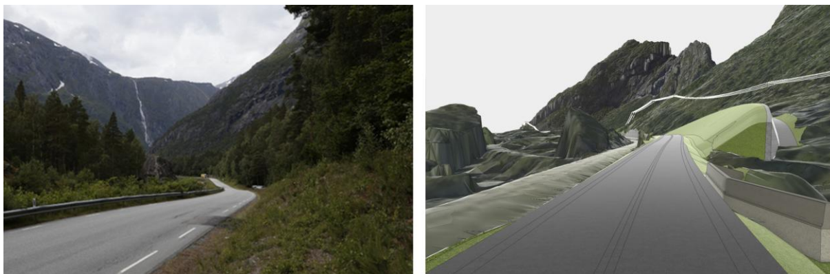
Figur 122: Foto og visualisering av veien ved Utøyan. Den 5 m høye og 300 m lange skredvullen vil utgjøre et merkbart element i dalsiden. Kilde: Grindaker/Trimble Connect
