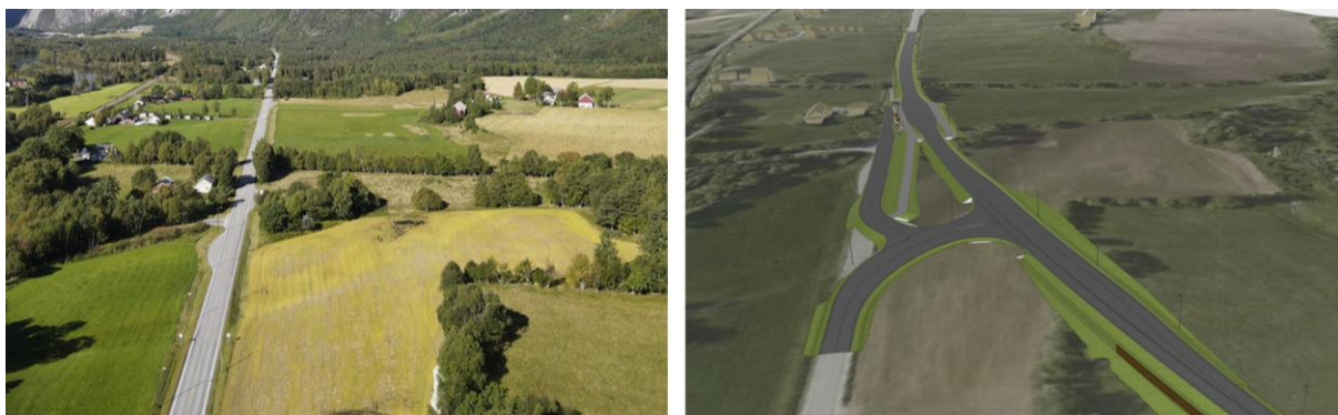
Figur 147: Dronefoto og modellbilde av krysset der ny vei møter gamleveien ved Alnestrøa. Kilde: Grindaker/Trimble Connect
