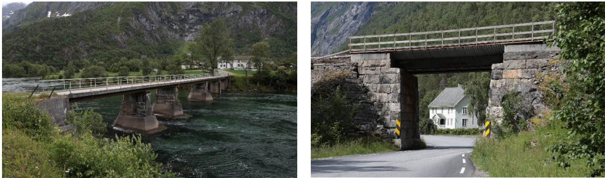
Figur 44: T.v. Brua over Rauma til Remmem gård. T.h. Jernbanebru over E136 ved skirimoen. Foto: Grindaker
