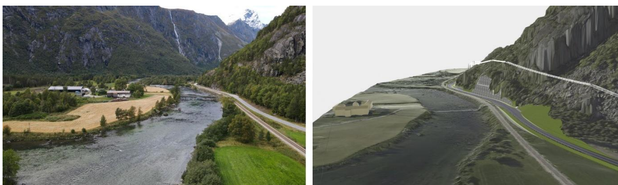
Figur 129: Dronefoto og visualisering av veien langs Mongehamran. Veiens utvidede bredde vil medføre en større løsmasseskjæring og en høy fjellskjæring. Kilde: Grindaker/Trimble Connect
