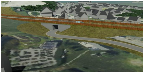
Figur 20 Ny gang-/sykkelvei med kulvert under E136. Sett fra Nukengata (øst).
