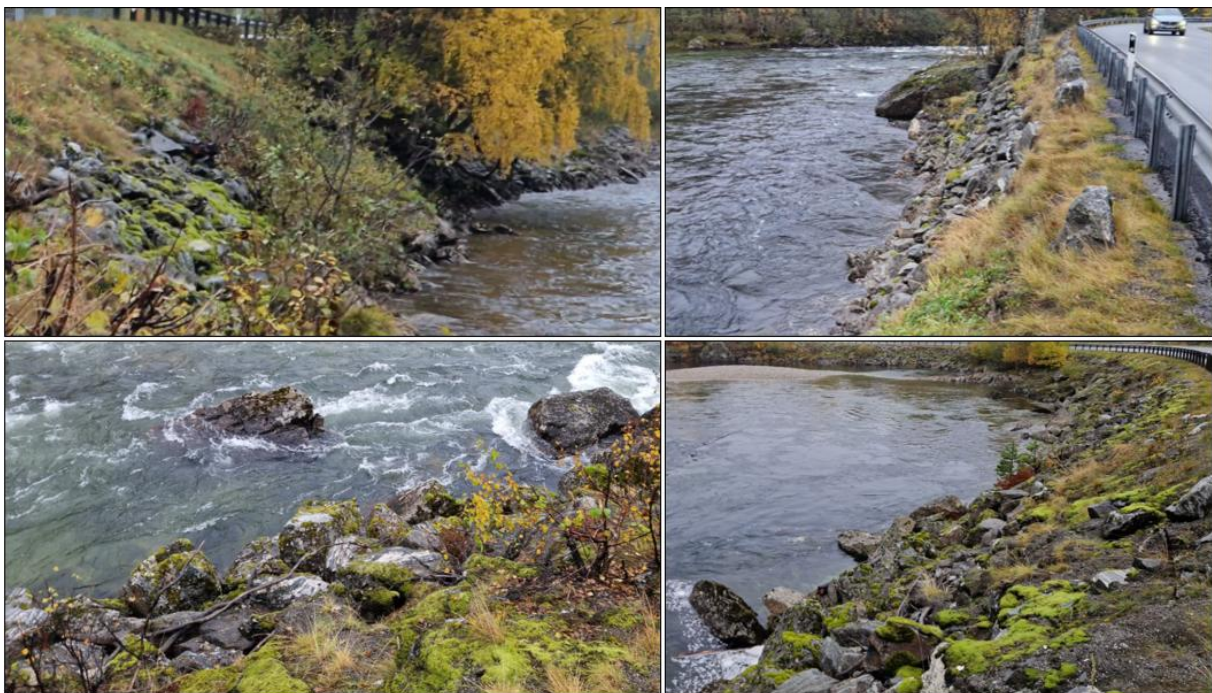
Figur 5-4 Bilder fra befaring 09.10.2024 som viser eksisterende erosjonssikring ved Nordre Flatmark (øverst) og Jetmundhølen (nederst).
