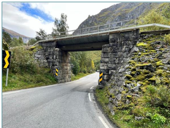
Figur 1-4 Jernbaneundergang ved Skirimoen. Kilde: AAV.
