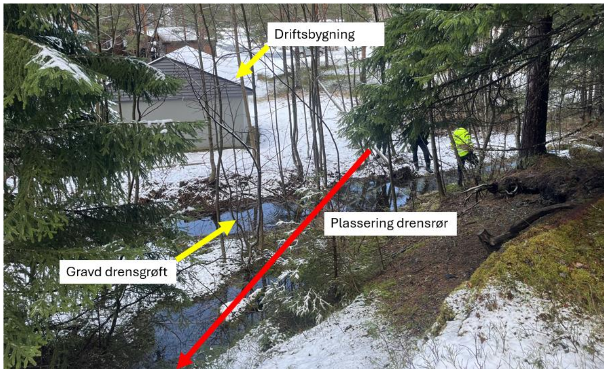
Figur 4-2 Oversiktsbilde som viser plassering av drenerør, og oppkomme i bunn av breelvterrasse.
