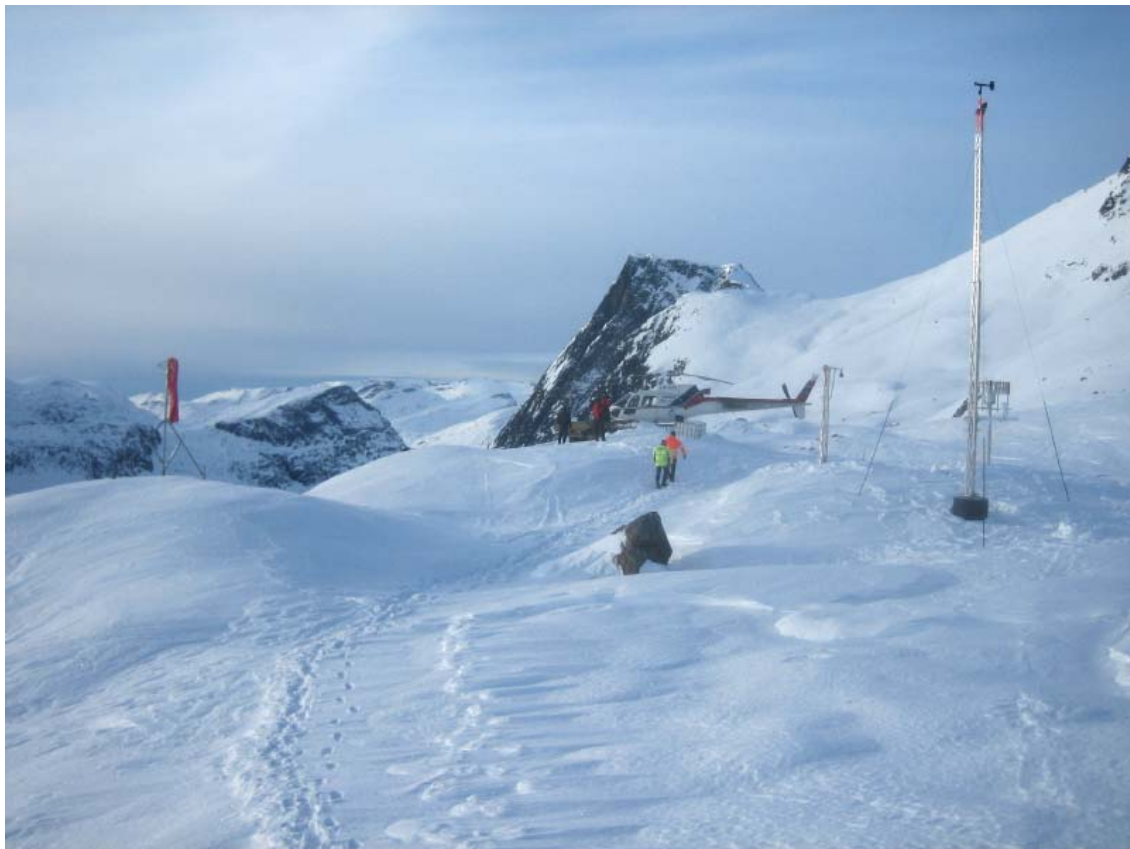
Bygging av skredvarslingsanlegg ved "Mannen"
