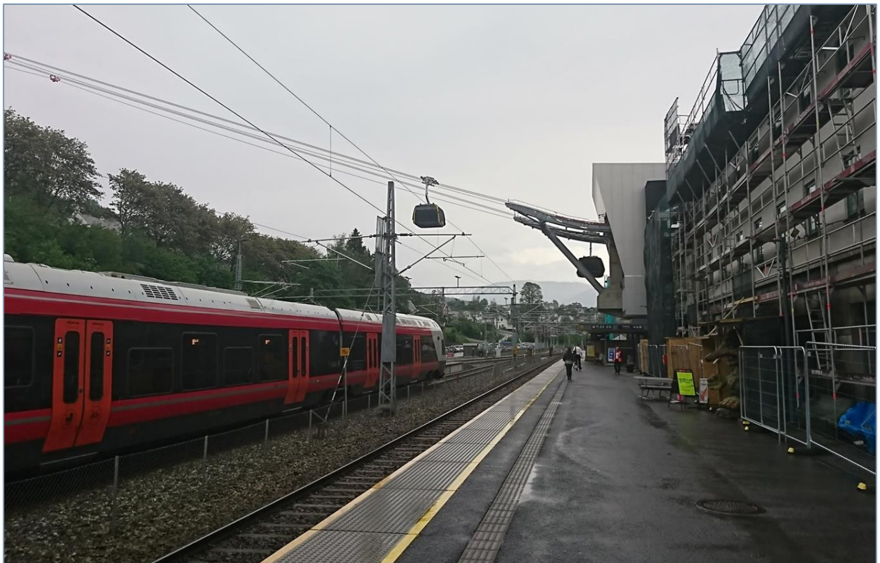
Figur 66: Bilde er frå nesten ferdig anlegg på Voss og viser gondolbane over straumførande linjer for tog (Norplan).
