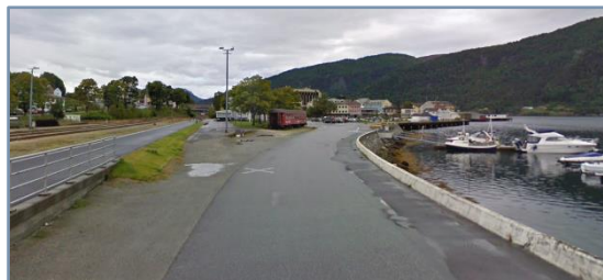
Figur 68: Bilde er frå 2010 men stemmer med eksisterande situasjon i veg ved båthamn og togstasjon (Google.maps).
