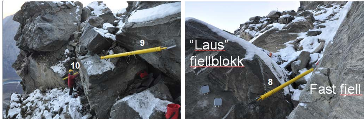
Figur 3. Bilde som syner strekkstaga i området. Det er strekkstag 8 som er festa mellom fast fjell og den øvre fjellblokka som syner rørslar.
